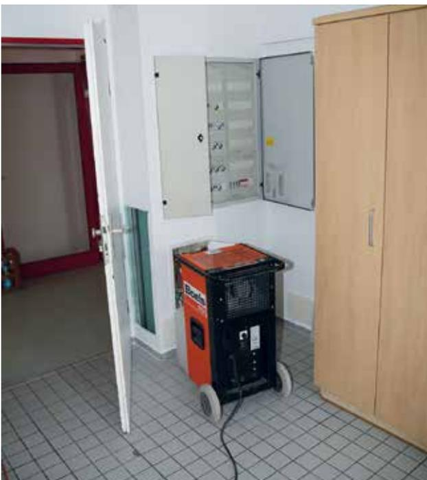
Foto oben: Trocknungsgerät vor einem defekten Sicherungskasten. Hinter dem Sicherungskasten befindet sich der Versorgungsschacht, in den das Wasser hineingelaufen ist.
